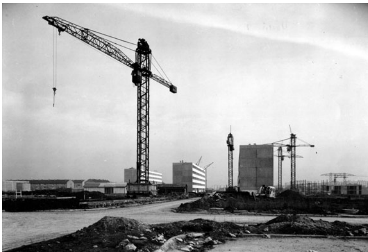
Vue du chantier du grand ensemble de Massy-Antony. © METATTM/SIC.
