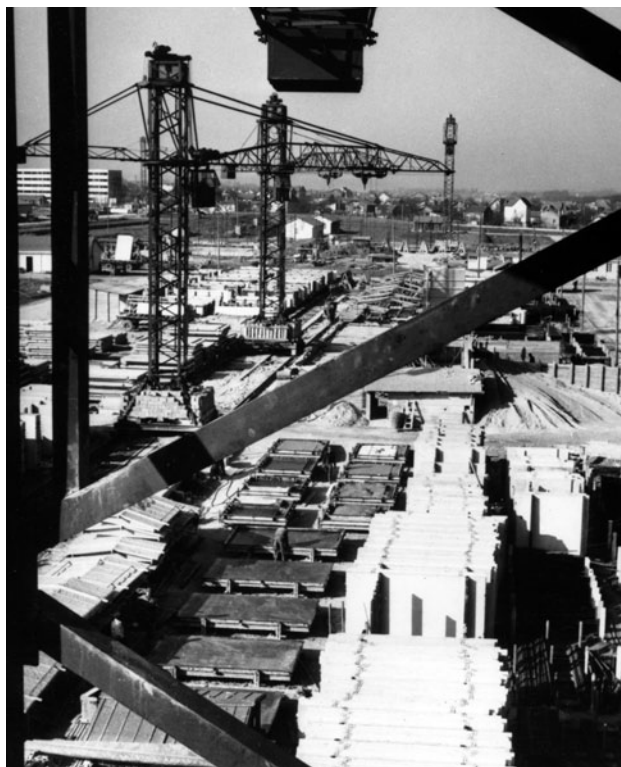
Aire de préfabrication des éléments muraux, avenue de Morangis, mai 1959. Coll. Groupe immobilier 3F, MdBA.
