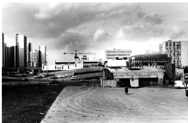
Le centre-ville en construction, fin des années 1970. © Photothèques des Ulis/Ville des Ulis.
