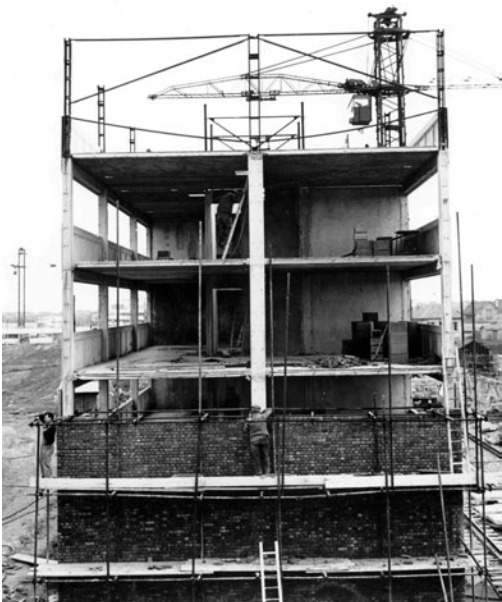
Montage en brique du pignon d'un immeuble, janvier 1959.
