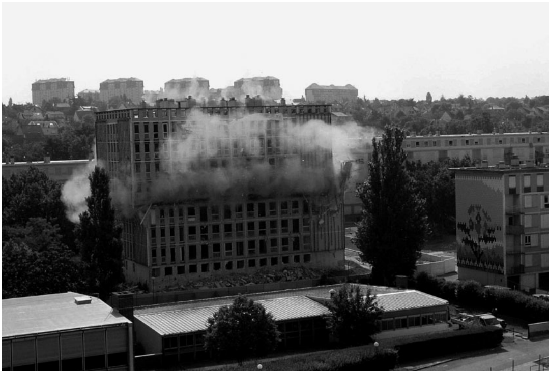
Prairie de l'Oly, à Montgeron. Démolition d'une des tours. © Service communication de la ville de Montgeron.
