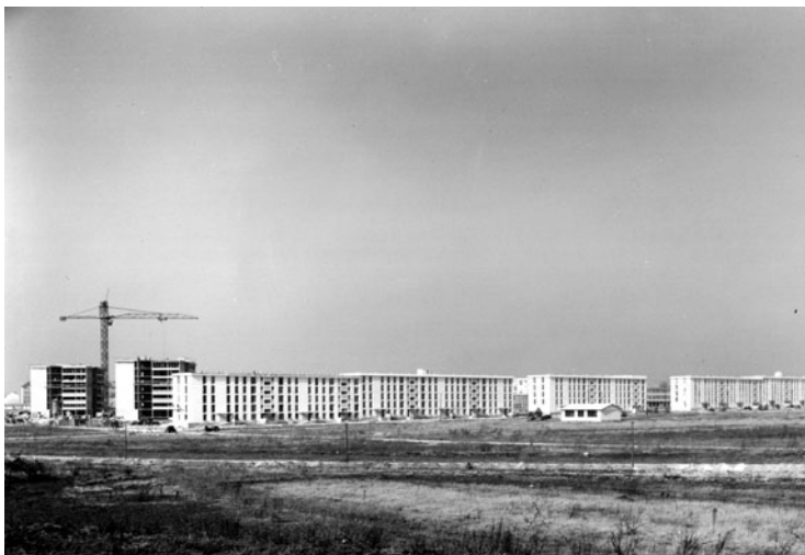
Chantier de construction Semidep, années 1960.
