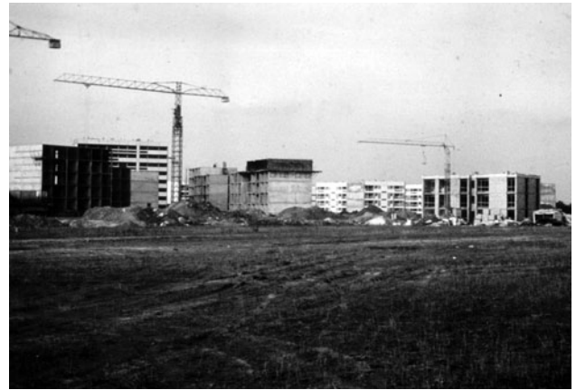
Le chantier des Bathes, en 1969. © Photothèques des Ulis/Ville des Ulis.
