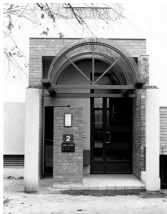
Entrée d'immeuble réhabilitée, 1990. Coll. municipale, MdBA.
