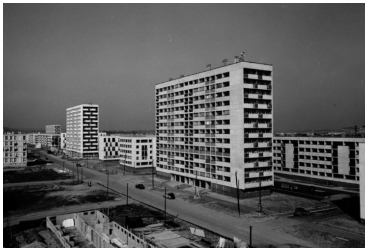
Chantier de construction Semidep, années 1960. © METATTM/SIC.
