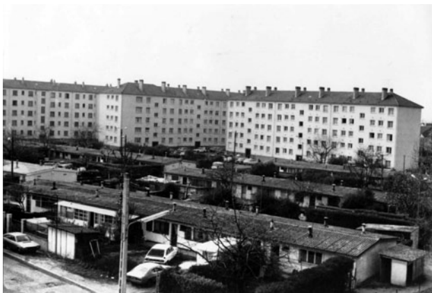
La cité d'urgence au premier plan construite en 1955, immeubles de la société HLM l'Athégienne en second plan, vers 1975. Coll. Gouzy-Bardy, MdBA.
