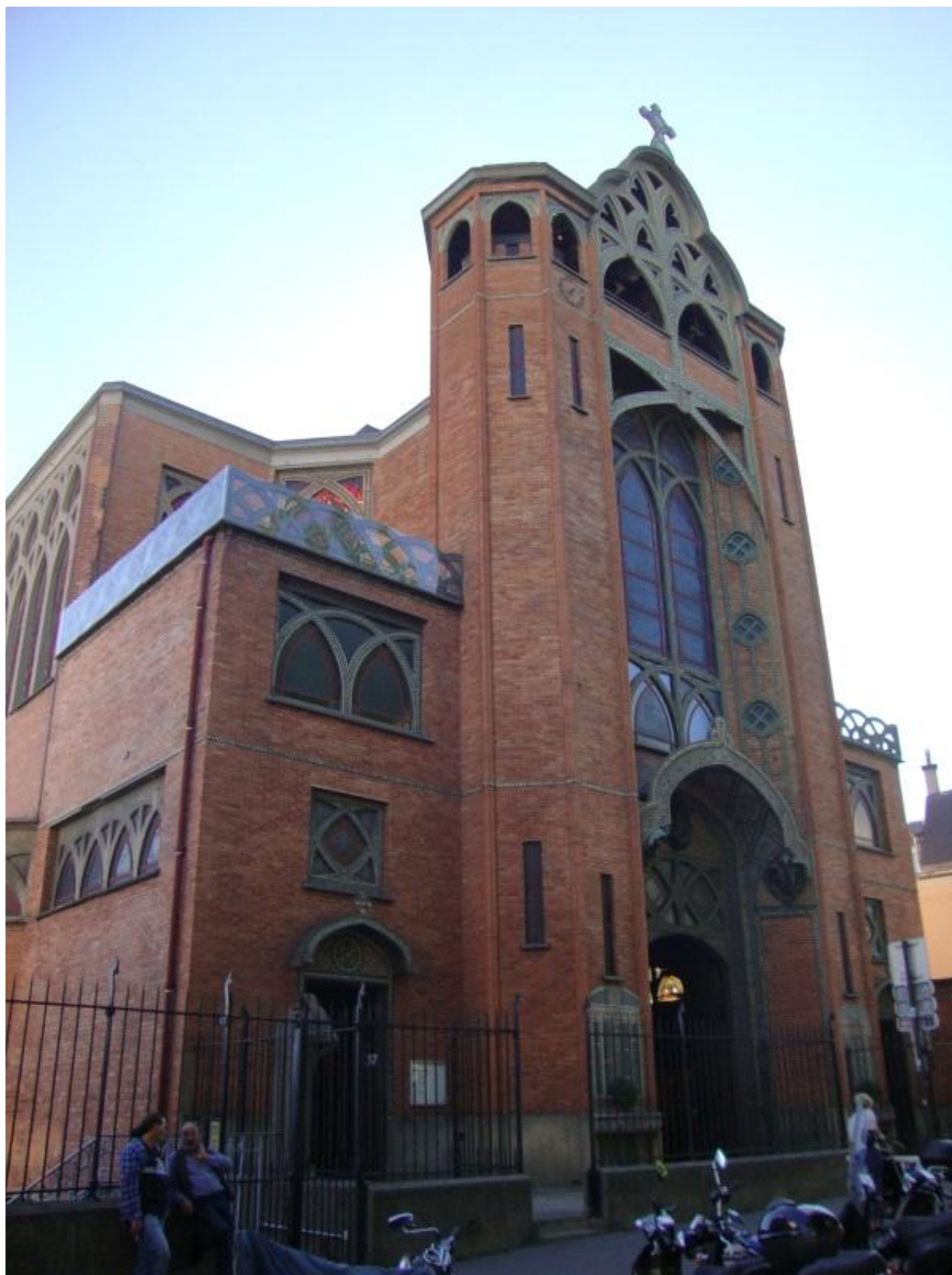
Document 12 : L'église Saint-Jean-de-Montmartre (1894-1904), par l'architecte Anatole de Baudot :
